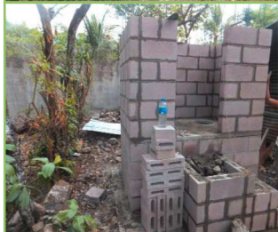
Diferentes fases de construcción de las letrinas
