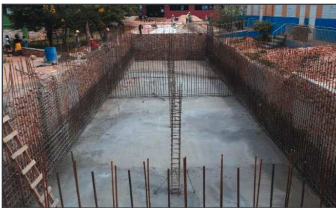
Proyecto para paliar la falta de agua potable mediante un sistema de recogida de agua de lluvia en Bois Tombé. Haití
