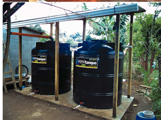
Fotografía superior: una de las familias realiza las obras para la instalación de los depósitos de agua potable. Fotografía inferior: aljibes instalados cóniguos a la casa de una familia beneficiaria
