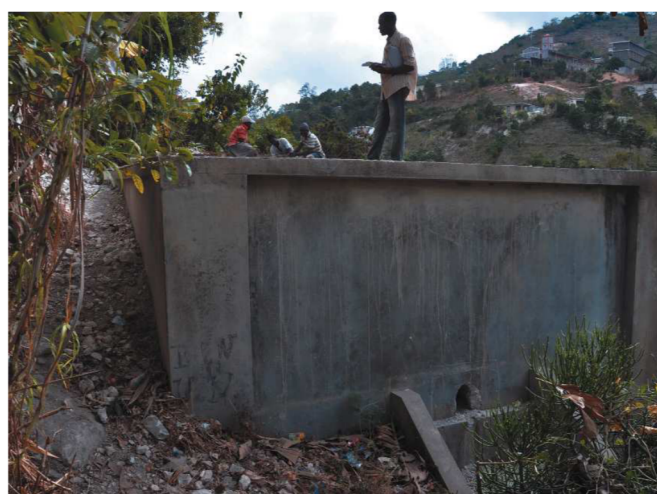
Éste es el sólido aspecto de la cisterna que se encontraba en desuso, una vez realizado el trabajo de rehabilitación
