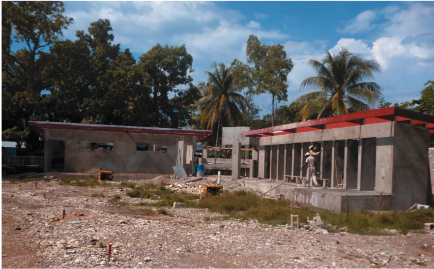
Momento de la reconstrucción y mejora de las infraestructuras de la escuela Santa Rosa de Lima, actualmente con capacidad suficiente para la actividad docente y equipada para su correcto funcionamiento
